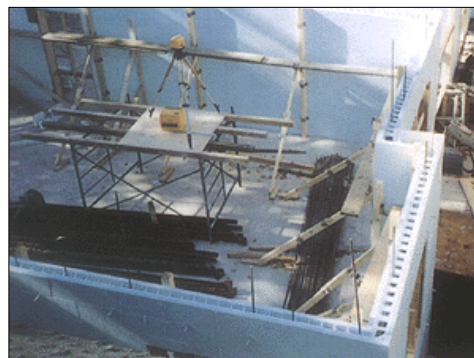
Συστήματα δόμησης με παραμένοντα ξυλότυπο από ηχοθερμομονωτικό υλικό
