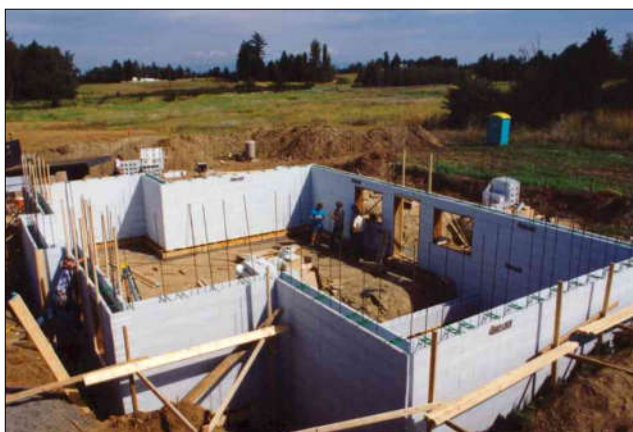
Συστήματα δόμησης με παραμένοντα ξυλότυπο από ηχοθερμομονωτικό υλικό
