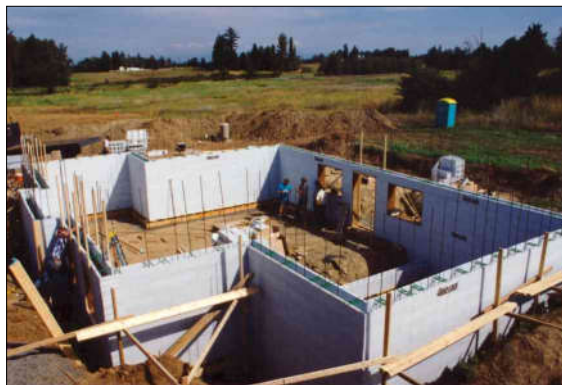
Διάφορες φάσεις κατασκευής
